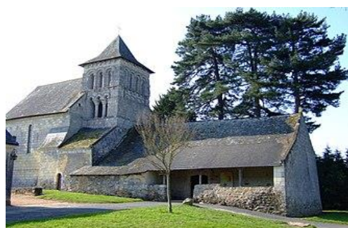
St Georges-des-7-Voies - Eglise St Barnabé
